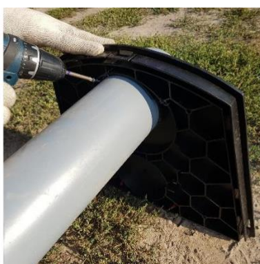
Sujetar con un tornillo el tubo.
