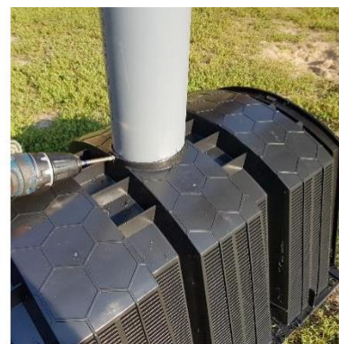
Instalar la chimenea de ventilación.
